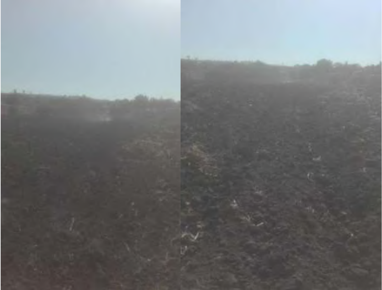
Figura 4.3 Preparación del terreno
