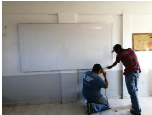
Fotografía 43. Trabajos de mantenimiento en los salones del Instituto.
