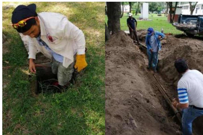
Fotografía 41. Trabajos en registros eléctricos del Instituto.
