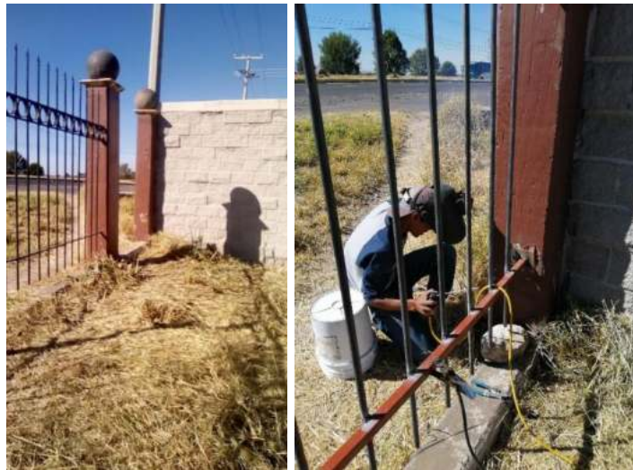
Fotografía 40. Trabajos en barda perimetral del Instituto.
