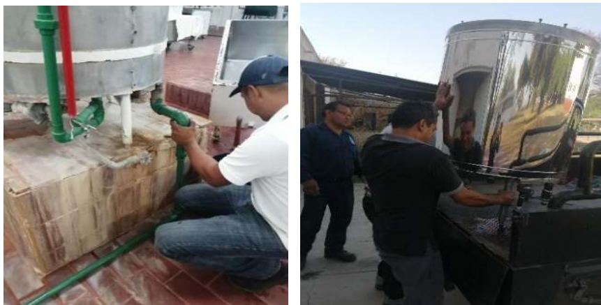
Fotografía 30. Mantenimiento de correctivo de pasteurizador.
