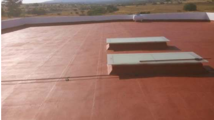
Fotografía 33. Trabajos de impermeabilización con la mano de obra del H. Ayuntamiento de Apaseo el Alto.
