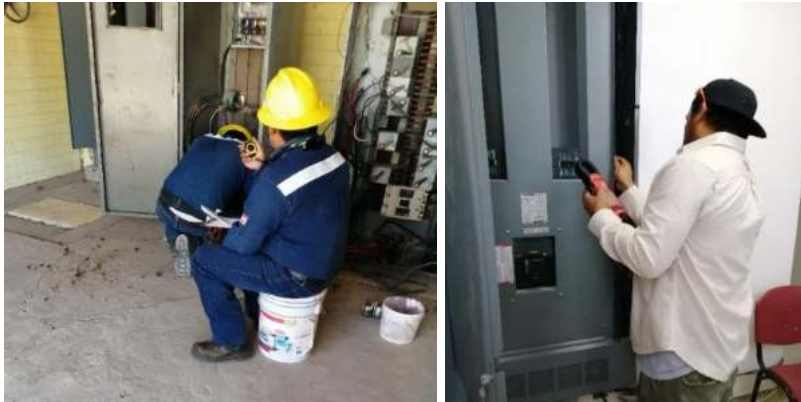
Fotografía 37. Trabajos de instalación eléctrica.
