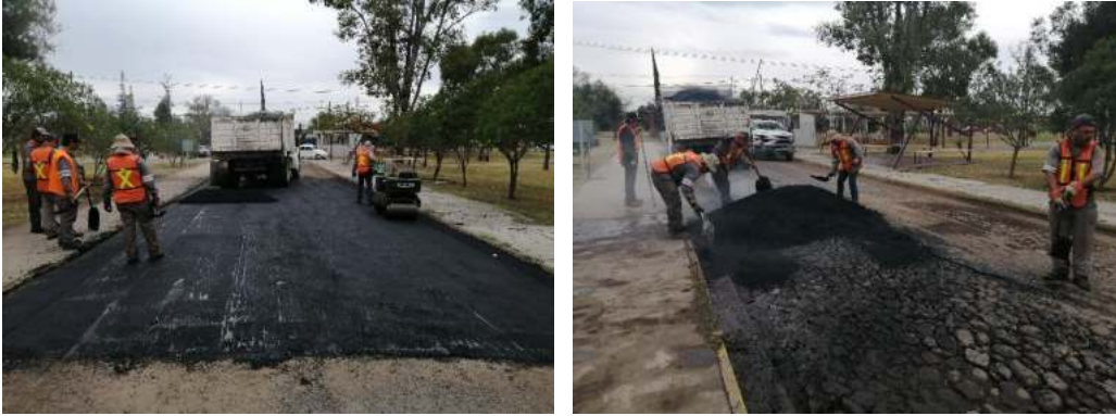
Fotografía 42. Trabajos de asfaltado en el Instituto por parte del Municipio de Celaya.
