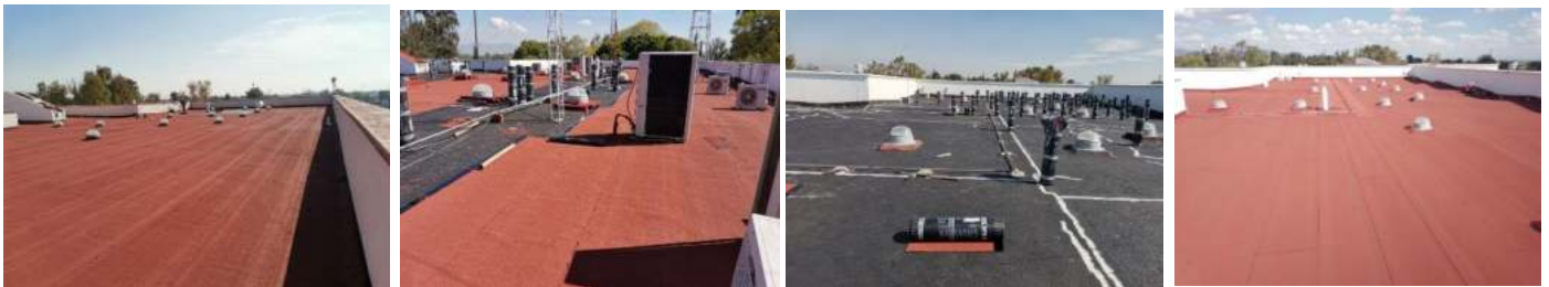
Fotografía 32. Impermeabilización de diferentes Departamentos.
