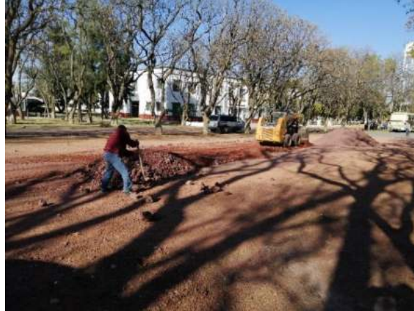
Fotografía 45. Trabajos de relleno de tezontle para estacionamiento.
