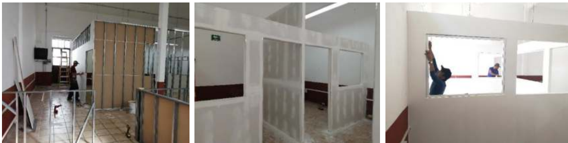
Fotografía 36. Trabajos realizados en el Instituto para habilitación de espacios.
