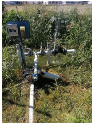
Fotografía 44. Trabajos de mantenimiento correctivo.
