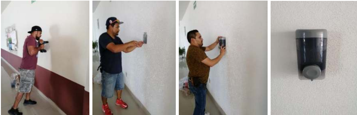
Fotografía 46. Trabajos de instalación de dispensadores de gel.
