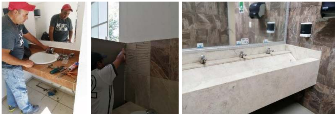
Fotografía 38. Trabajos de mantenimiento a sanitarios del Instituto.
