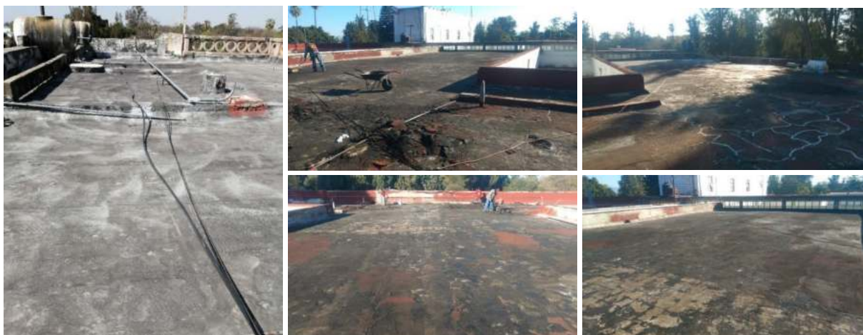
Fotografía 30. Trabajos de Impermeabilización de techos de oficinas del Instituto Tecnológico de Roque.
