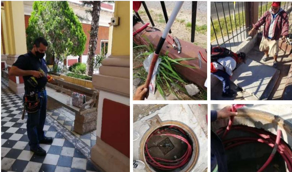
Fotografía 35. Mantenimientos eléctricos en el Tecnológico de Roque
