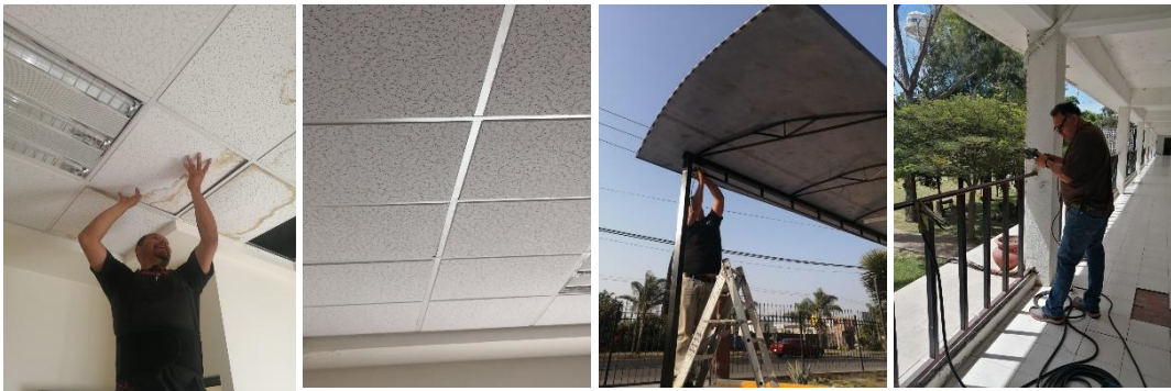
Fotografía 42. Mantenimiento a techos falsos y barandales.
