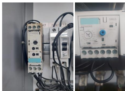
Fotografía 49. Mantenimiento a bomba del pozo 2
