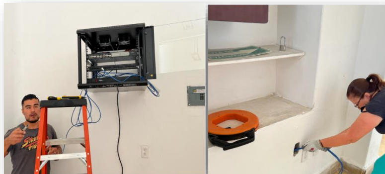
Fotografía 29. Instalación de red de datos en el Departamento de Recursos Humanos.
