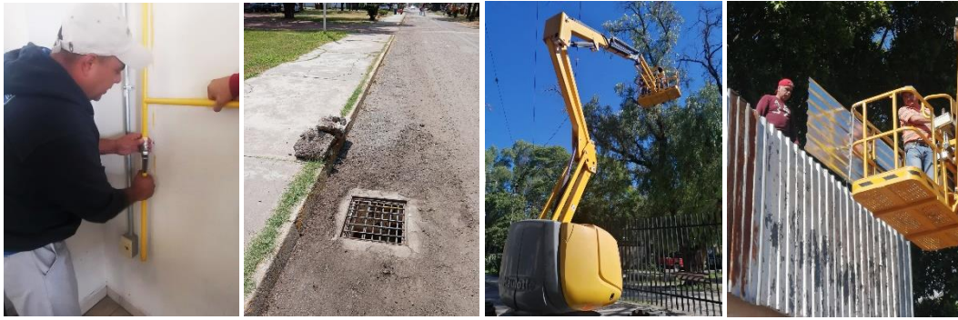
Fotografía 43. Mantenimiento a laboratorios, caminos, poda de árboles y gimnasio.
