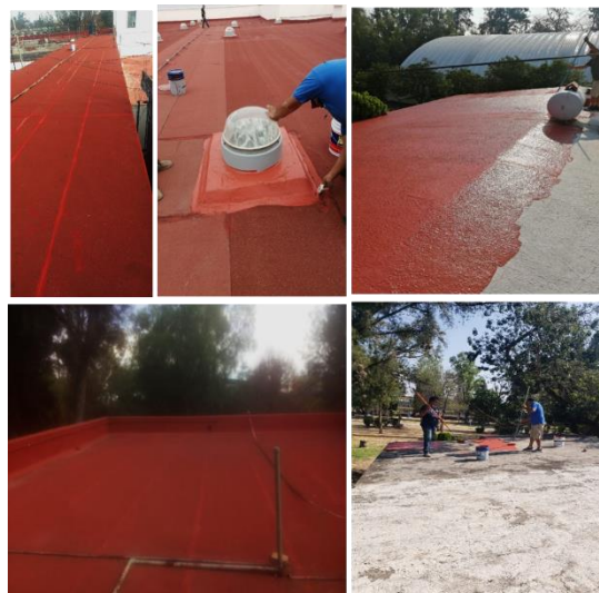
Fotografía 36. Impermeabilización de Edificios Académicos y Administrativos.
