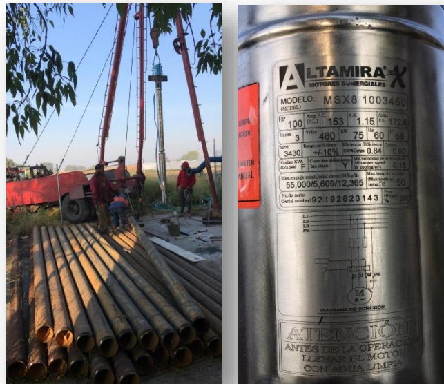
Fotografía 72. Reparación del pozo del TecNM-Roque
