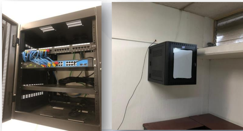
Fotografía 64. Instalación de cableado en el Departamento de Vinculación.
