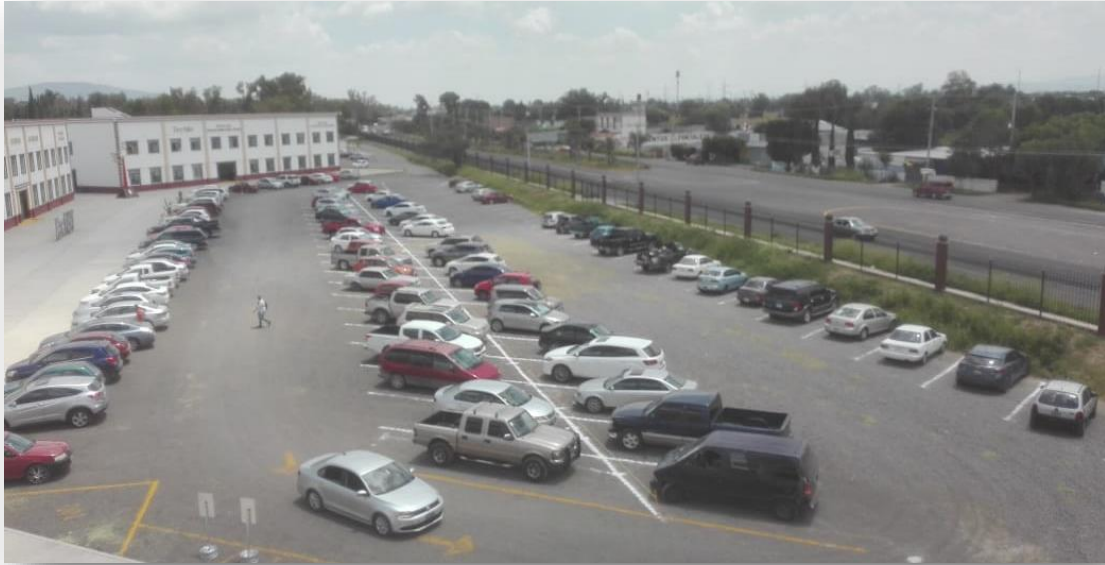
Fotografía 61. Mantenimiento a estacionamiento de edificios académicos.
