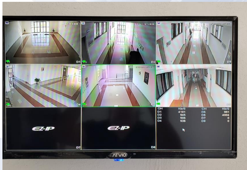
Fotografía 60. Instalación de cámaras en edificios académicos
