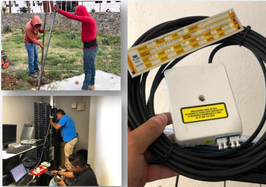
Fotografía 63. Instalación de fibra óptica en la Extensión de Apaseo el Alto.
