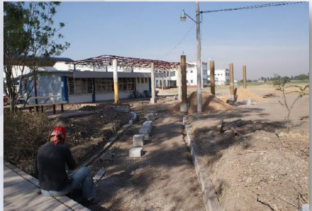
Fotografía 64. Habilitación de acceso peatonal e instalación de estructura metálica para la cafetería II
