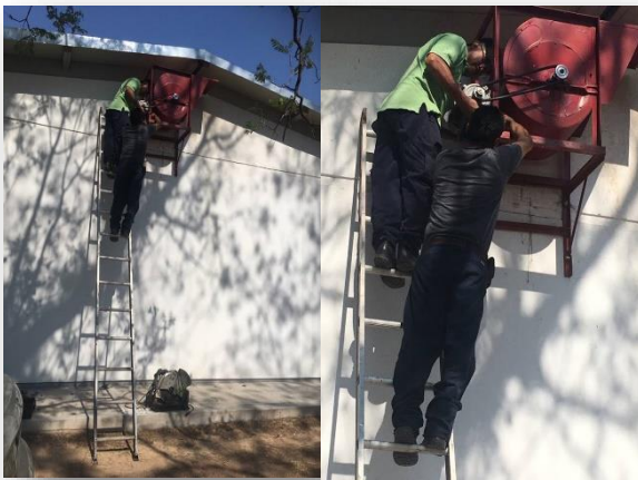
Fotografía 108. Mantenimiento a extractores de aire.
