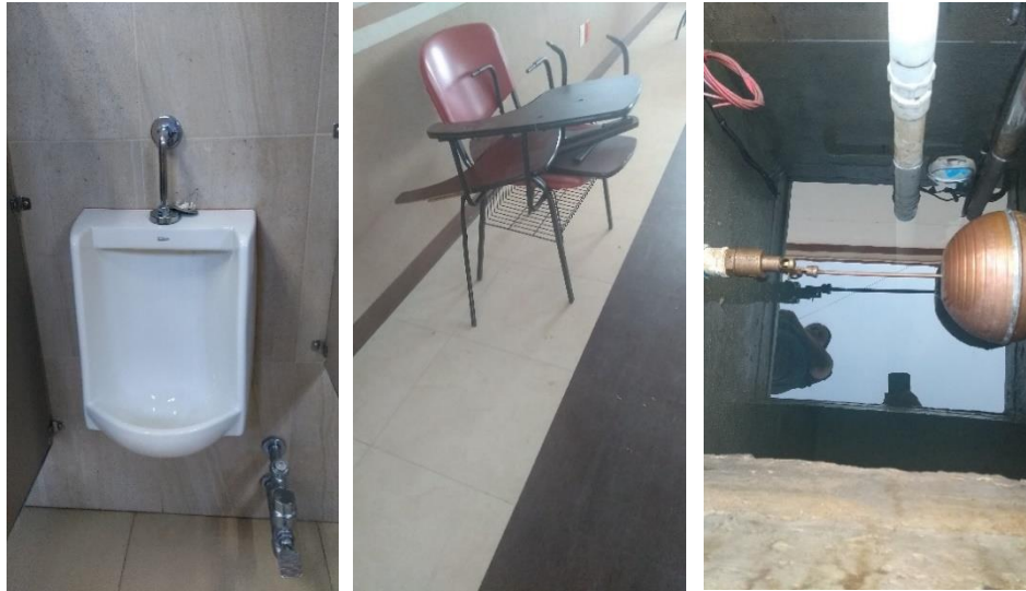
Fotografía 71. Mantenimientos preventivos y correctivos
