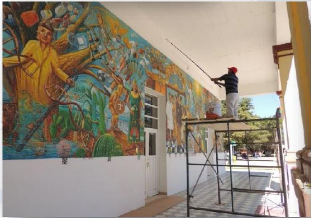
Fotografía 63. Aplicación de pintura a edificio principal
