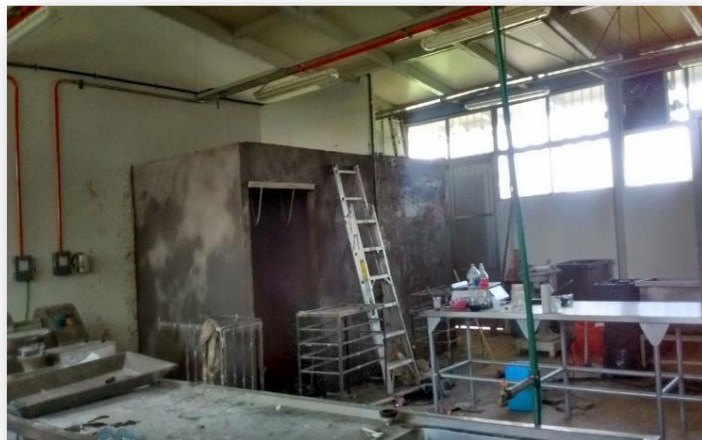
Fotografía 96. Remodelación del Taller de Carnes.
