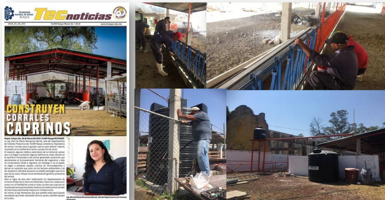
Fotografía 106. Construcción de corrales.
