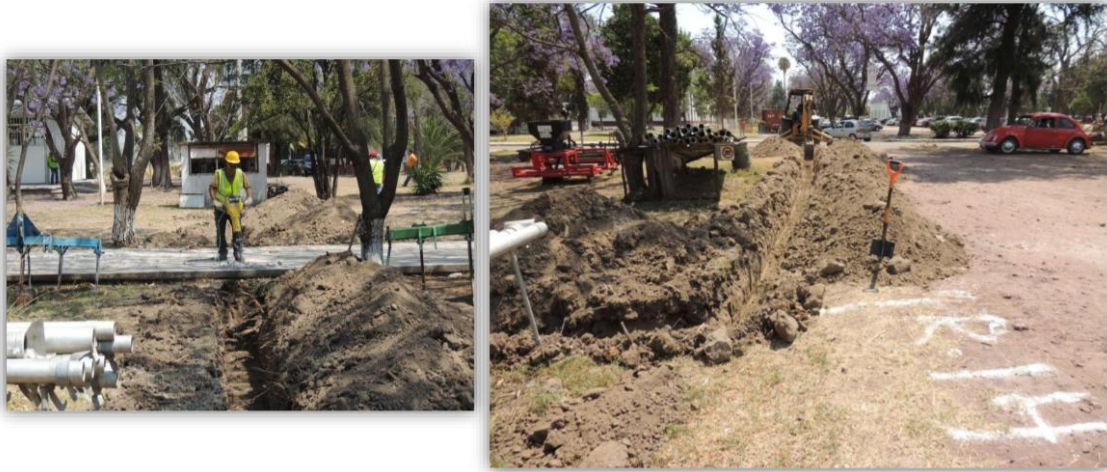
Fotografía 47. Excavaciones para el mantenimiento de la red
