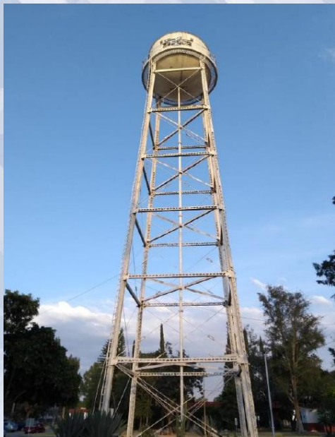
Fotografía 65. Mantenimiento a tanque elevado, consistió en soldar en su interior.
