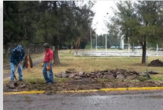
Fotografía 60. Rehabilitación de la banqueta peatonal del acceso 2
