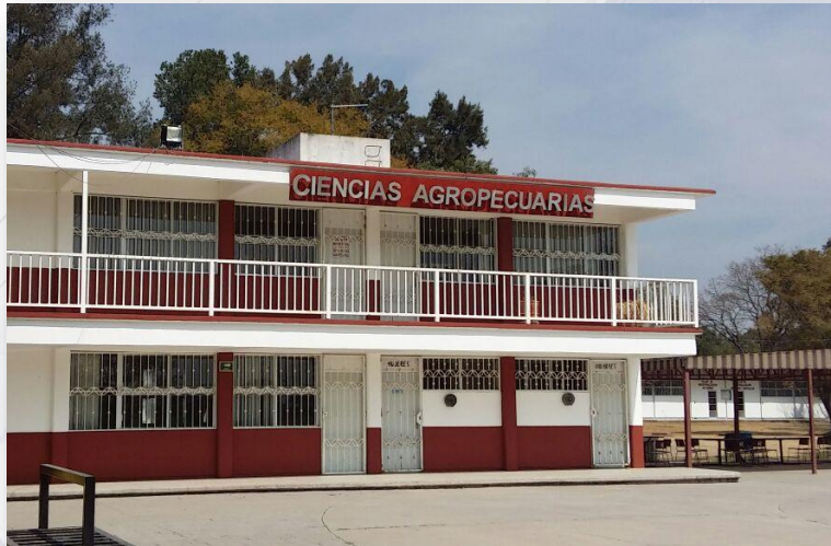
Fotografía 73. Mantenimiento a edificio de Ciencias Agropecuarias.
