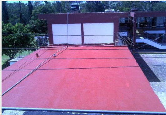
Fotografía 59. Impermeabilización de los edificios
