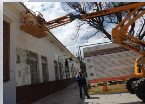
Fotografía 62. Mantenimiento a muros
