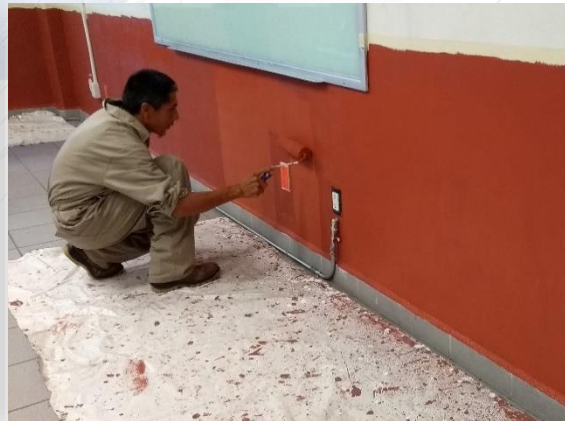
Fotografía 78. Mantenimiento a muros en la Extensión de Apaseo.
