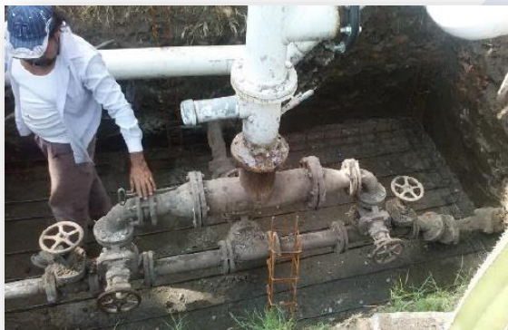
Fotografía 61. Rehabilitación de la red hidráulica.
