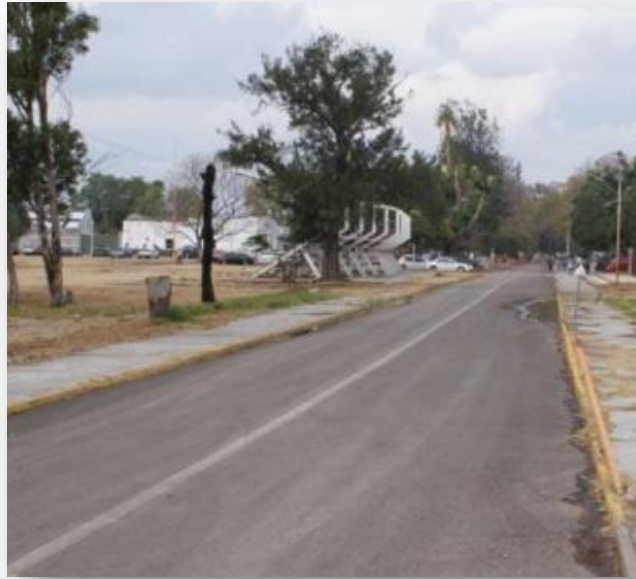
Fotografía 68. Pavimentación de asfalto
