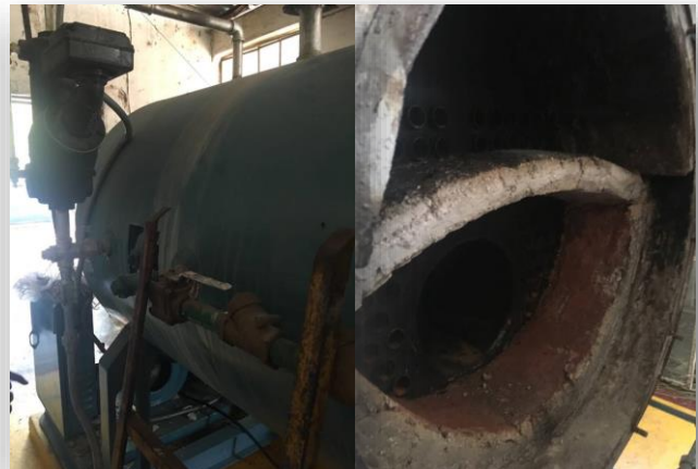
Fotografía 109. Mantenimiento preventivo a caldera.
