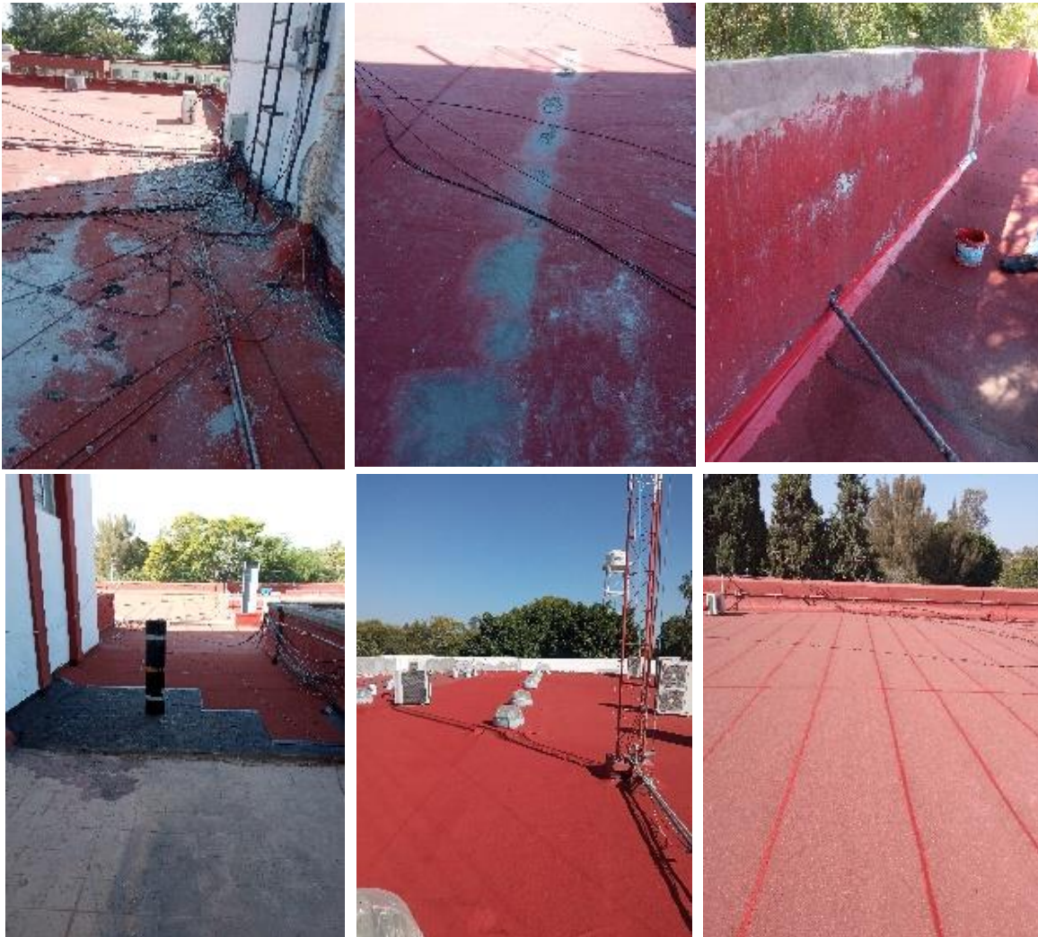
Fotografía 103. Trabajos de impermeabilización en el Instituto.
